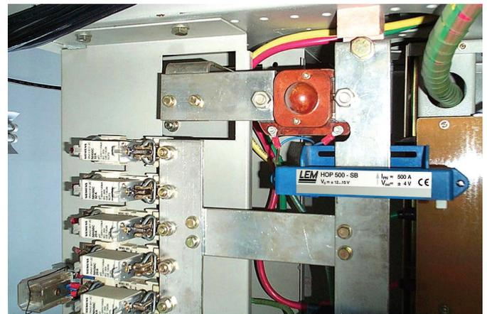
Рис. 10: Датчик тока серии HOP в китайской телекоммуникационной установке.
